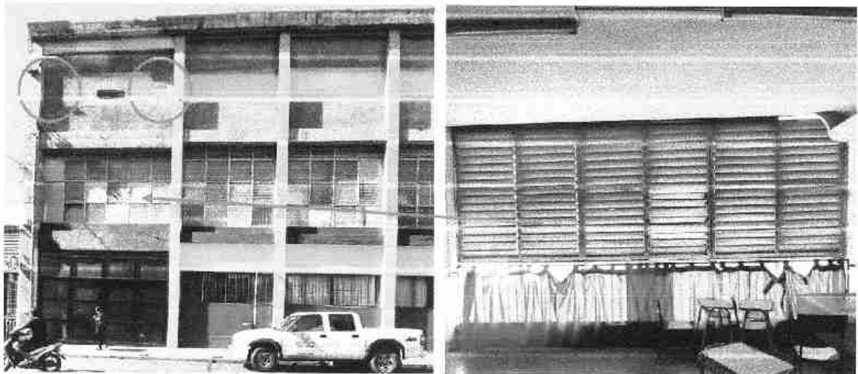
Frente con los parasoles colocados en el exterior.
