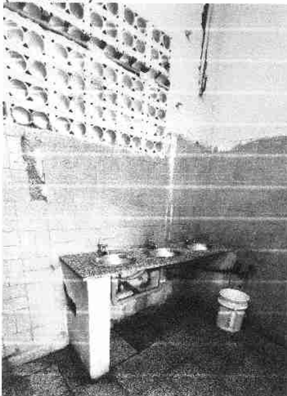
Reemplazar griferías mesada baños de Mujeres P.A. por grifería presmatic Fv (cantidad 3)
