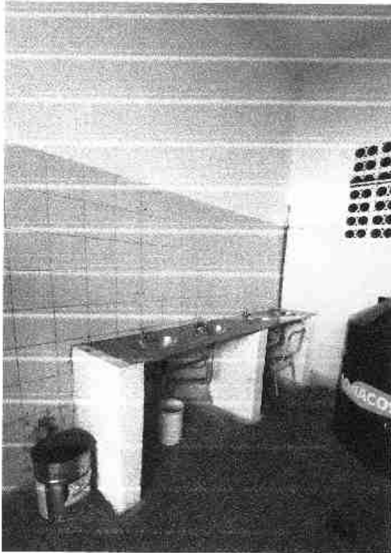
Reemplazar griferías mesada baños de Mujeres P.A. por grifería presmatic Fv (cantidad 4)
