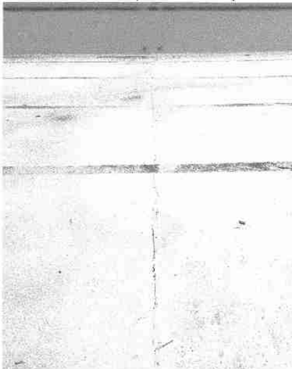
Imagen 8: Junta de dilatación en piso
