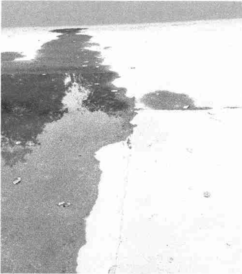
Imagen 9: Junta de dilatación en piso
