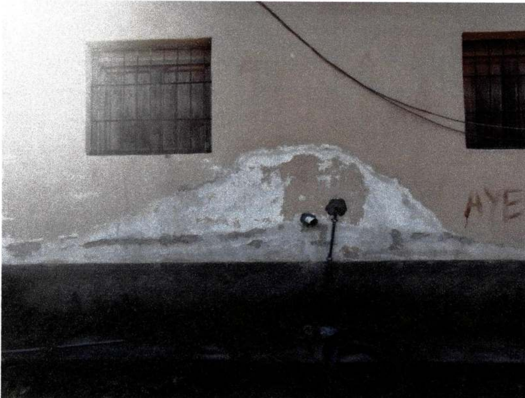
Descarga de las bachas del Laboratorio de Nivel secundaria- ahora utilizado como cocina de secundaria
